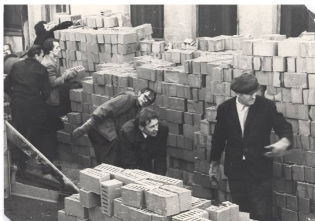
Рис. 2. Строительство нового здания ВГФ силами сотрудников
