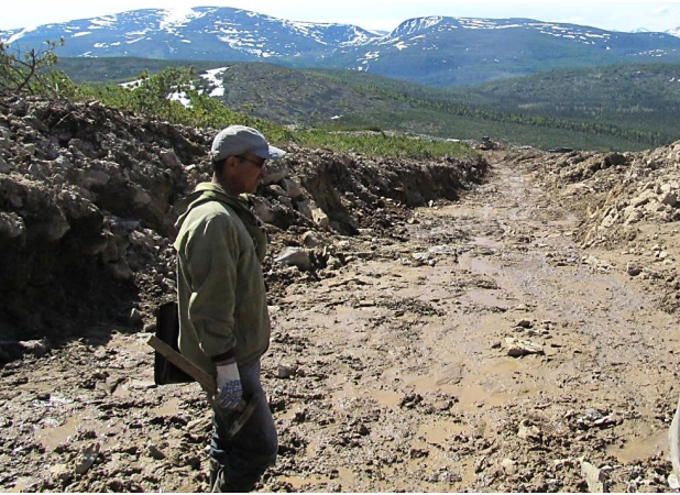
Рис. 4. Бульдозерная канава глубиной 1 м (расчистка), пройденная до многолетней мерзлоты (происходит её оттайка)
